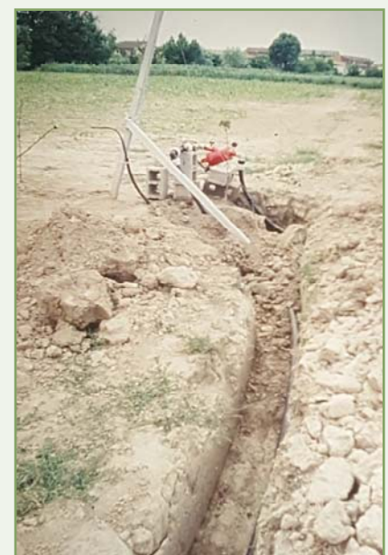
Messa in opera del sistema di irrigazione
